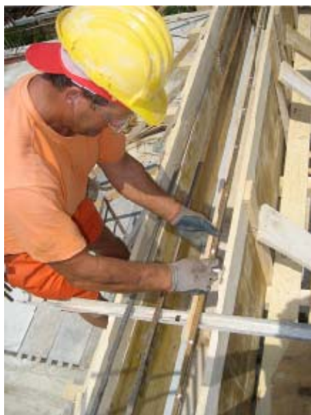
Fig. 3.2 – Viene segnato il passo delle staffe
