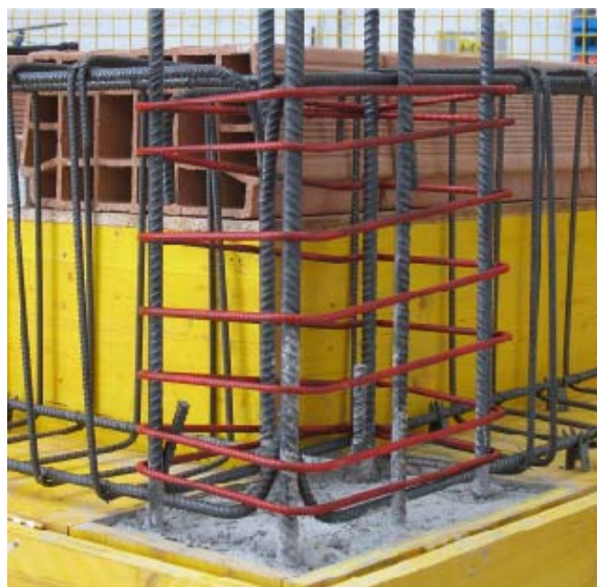
Fig. 3.15 – L'armatura del nodo con la staffa spirex
