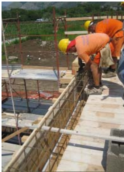
Fig. 3.4 – La gabbia di armatura resta sollevata fuori dalla cassaforma durante il montaggio
