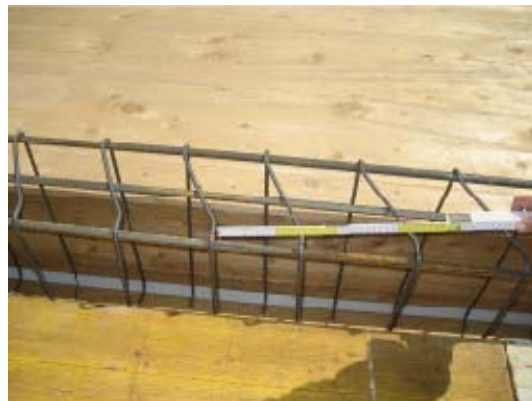
Fig. 3.9 – Montaggio gabbia metallica con staffa Spirex
