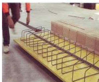
Fig. 2.21 – Montaggio armatura
