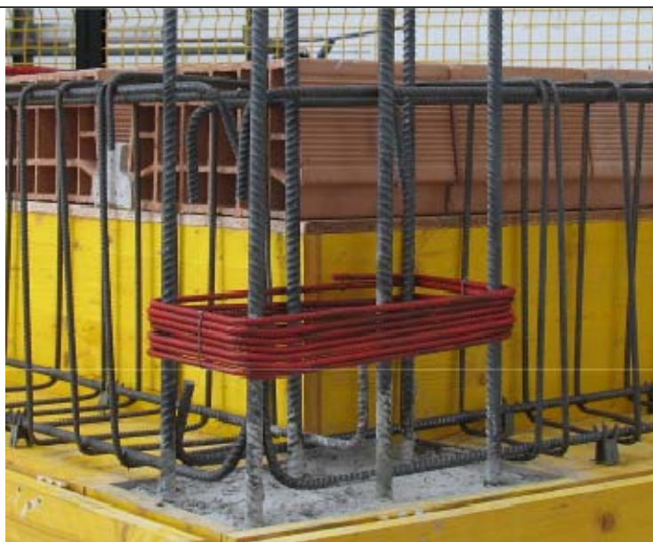
Fig. 3.14 – La staffa spirex per il nodo, ancora impacchettata in posizione centrale
